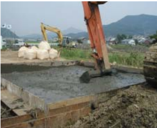
写真 1 津吹湖の底質土の汚泥改良工事
