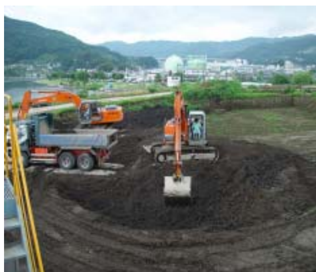
写真 - 3 諏訪湖浚渫土の固化改良工事
