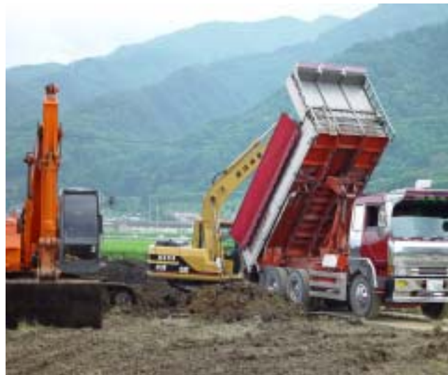
写真 4 諏訪湖浚渫改良土の田圃への埋戻
