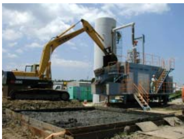
写真 2 環境に優しい土づくりの工事状況
